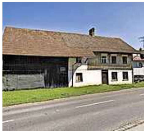
Das Haus in der Achstraße 51 ist noch im Originalzustand
