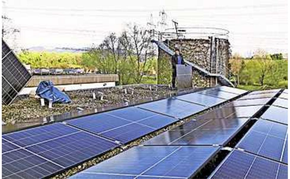
Vor einigen Tagen wurden die beiden Dächer der Gebläsehäuser mit Photovoltaik-Elementen besetzt. Diese beiden Dächer sind prädestiniert für eine PV-Anlage, da jeweils rund 100 Quadratmeter Platz zur Verfügung steht und kein Schatten aus der Umgebung auftreten kann.
